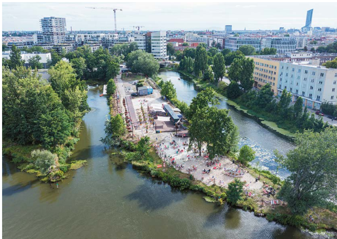
Dzięki budowie pływającego pomostu Port Węglowy jest dostępny z wody dla kajaków, łodzi i motorówek
